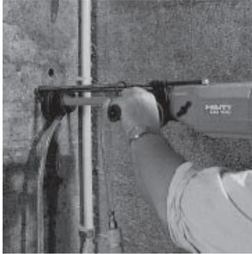
Appuyer la couronne de forage contre l'endroit où vous désirez forer en tenant le collecteur d'eau (disque d'étanchéité, disque troué de centre). Appuyer sur le variateur électronique pour mettre l'appareil en marche.
