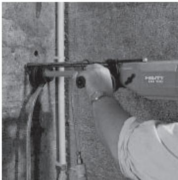
壓著穿過集水器（密封片、中心環）的鑽石鑽頭於待鑽的工作面，起動DD100開關。
