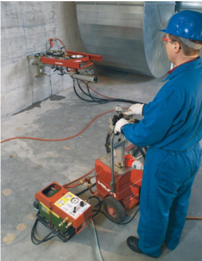
Schalten Sie den Hauptantrieb DS WS10 ein und lassen Sie das Sägeseil anlaufen.
