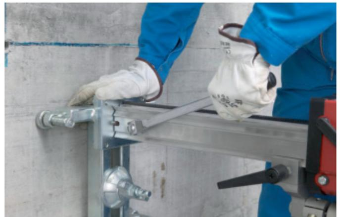
Exzenterbolzen im Uhrzeigersinn festziehen.
