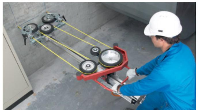
Legen Sie das Sägesegels über die Umlenkrollen und das Antriebsrad, und spannen Sie dieses leicht durch das Verfahren der Antriebseinheit (Kolbenstangenklemmung geöffnet).
