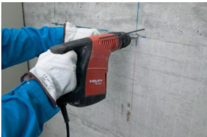
Die Lage und Position der Durchführungsbohrungen hat einen direkten Einfluss auf die Genauigkeit des Schnittes. Bei grossen Wanddicken oder kleinen zulässigen Toleranzen empfehlen wir Ihnen daher die Durchführungen mittels ständergeführtem Diamantbohrgerät zu bohren.
