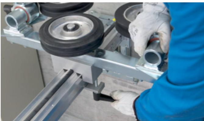
Befestigungslasche schliessen und Spannhebel festziehen.
