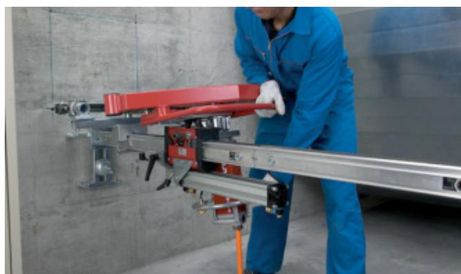
Направьте зажимаемый участок в паз каретки.
