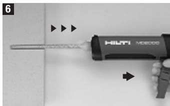
Borrhål måste fyllas med injekteringsmassa utan att luftfickor bildas. För därför in blandningsröret ända till botten (**vid djupa borrhål, använd förlängarell!**) och drag för varje tryck pistolen långsamt tillbaka. Antal tryck per ankardimension framgår av anvisningarna för folieförpackningarna.
