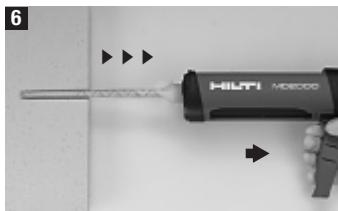
Porareikä on täytettävä massalla niin, että reiän pohjalle ei jää ilmaa. Siksi sekoituskärki on vietävä porareiän pohjalle (**syvissä reiissä käytettävä jatkoputkeal**) ja puristinta on vedettävä jokaisen puristuksen yhteydessä hitaasti ulospäin. Puristusten lukumäärä eri kokoisille ankkureille on kerrottu patruunan käyttöohjeessa. **Tärkeää! Jos jätät tämän seikan huomiotta, kiinnityksen kuormituskyky heikkenee.**
