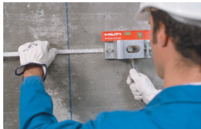
1. Dübelbohrungen für Schienenfussmontage anzeichnen
